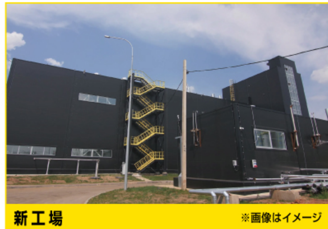
新工場 ※画像はイメージ 2023年4月稼働予定
