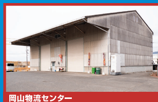
岡山物流センター
